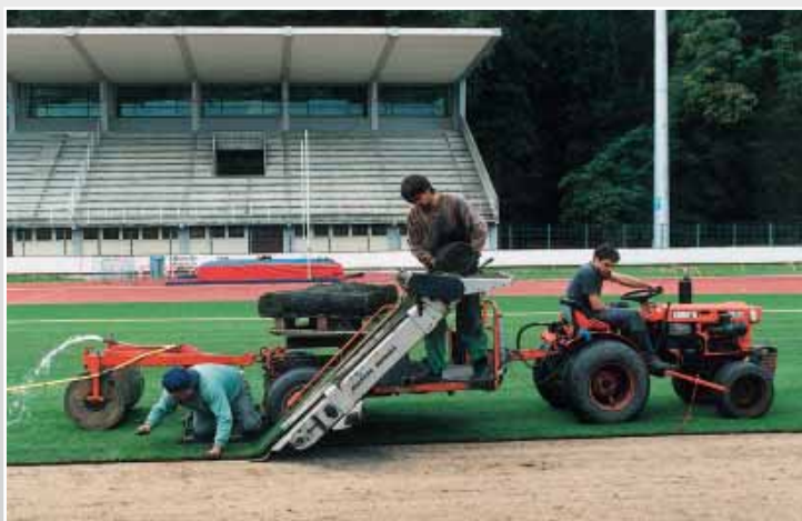
Roulage et arrosage simultanés pour une reprise parfaite du gazon Stade des Allées Blois (41)
