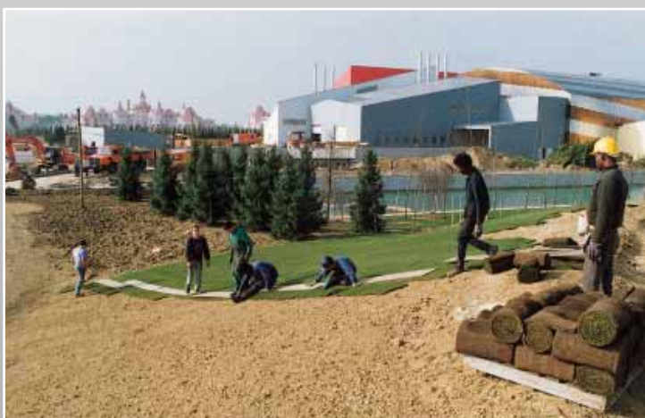
Dysneyland Paris - Fourniture et pose de 25 ha de gazon sous des contraintes de chantier exceptionnelles
