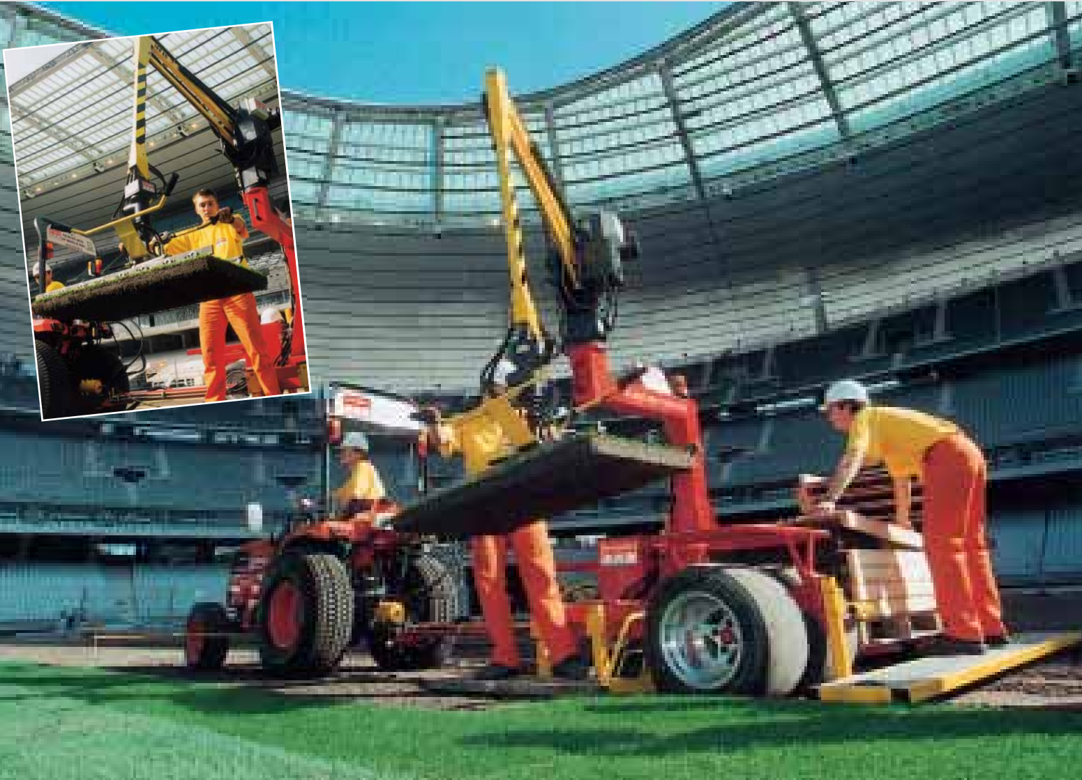
ROPIX ® : machine robot pour pose de pavés - Stade de France
