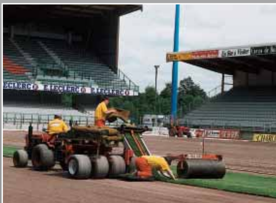
Replaqueuse MPG 2000 ® pose de rouleaux Stade d'Auxerre
